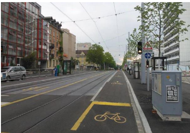
Abb. 1: Situation Haltestelle Hünigerstrasse
