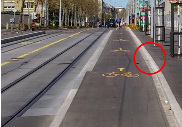
Abb. 4 Haltestelle Hünigerstrasse, taktile erfassbare Abgrenzung
