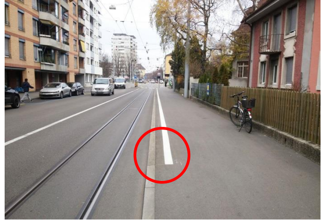
Abb. 5 Haltestelle Kleinhüningen, optische Markierung der Haltekante (hier keine Veloführung über das Kap)
